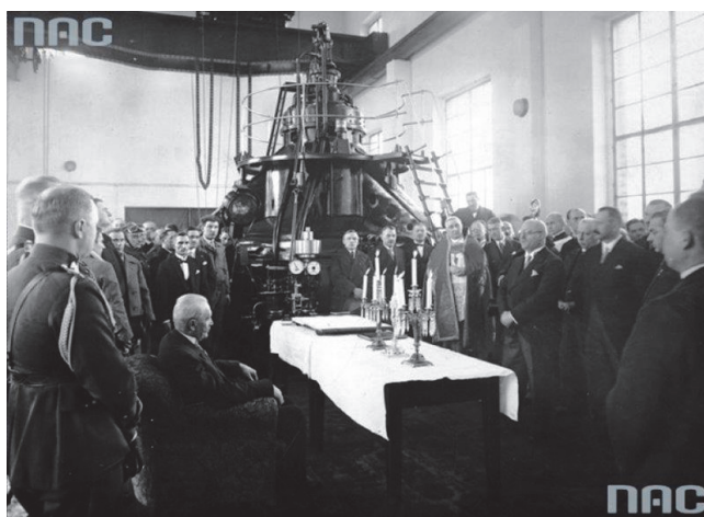
Fot. 11. Uruchomienie elektrowni wodnej w Żurze z udziałem Prezydenta Mościckiego (15.02.1930 r.) [9]
